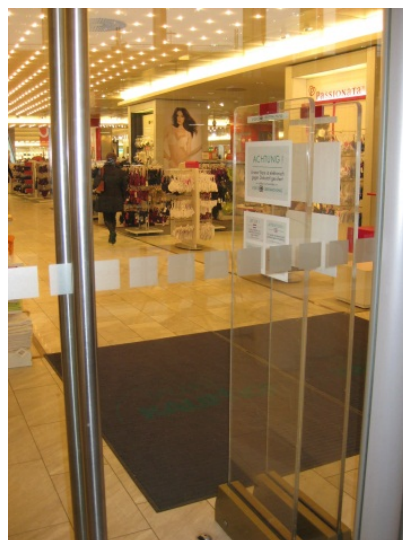
Beispiel für eine Eingangstür mit Markierung (Quelle: Galeria Kaufhof)
